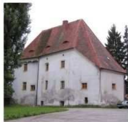
Pohled z prostoru dvora
