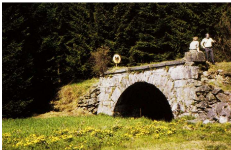
Starý hraniční most přes Mechový potok
