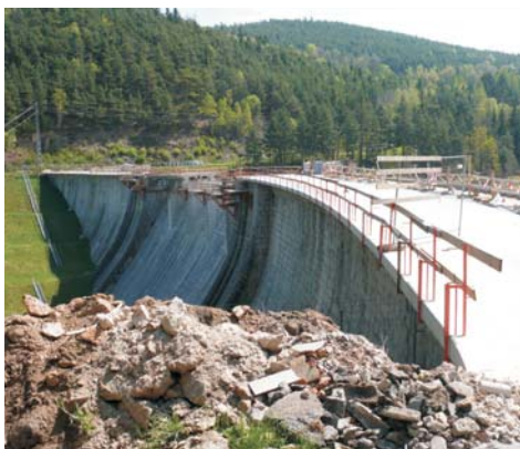
Oprava koruny hráze Husinecké přehrady
