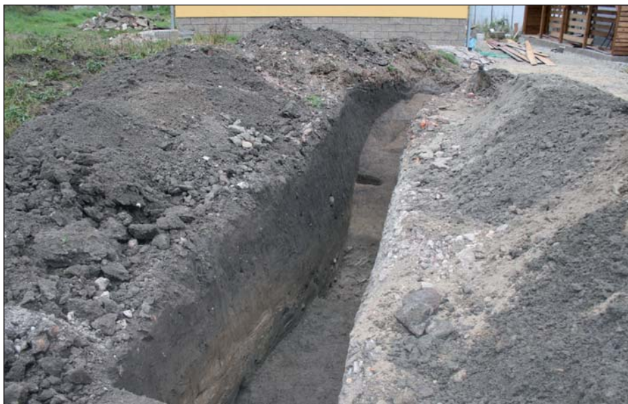
Výzkum u novostavby rodinného domu na parcele č. 125/2 v Netolicích
