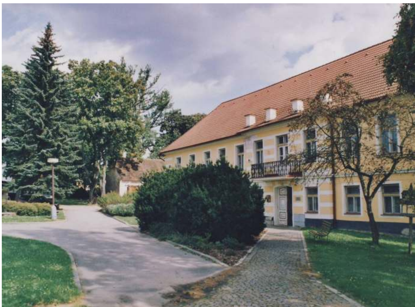
Hlavní průčelí zámku
